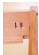
Mittelunterstützung mit Blindfüßen in Kopf- und Fußteilstollen stecken
